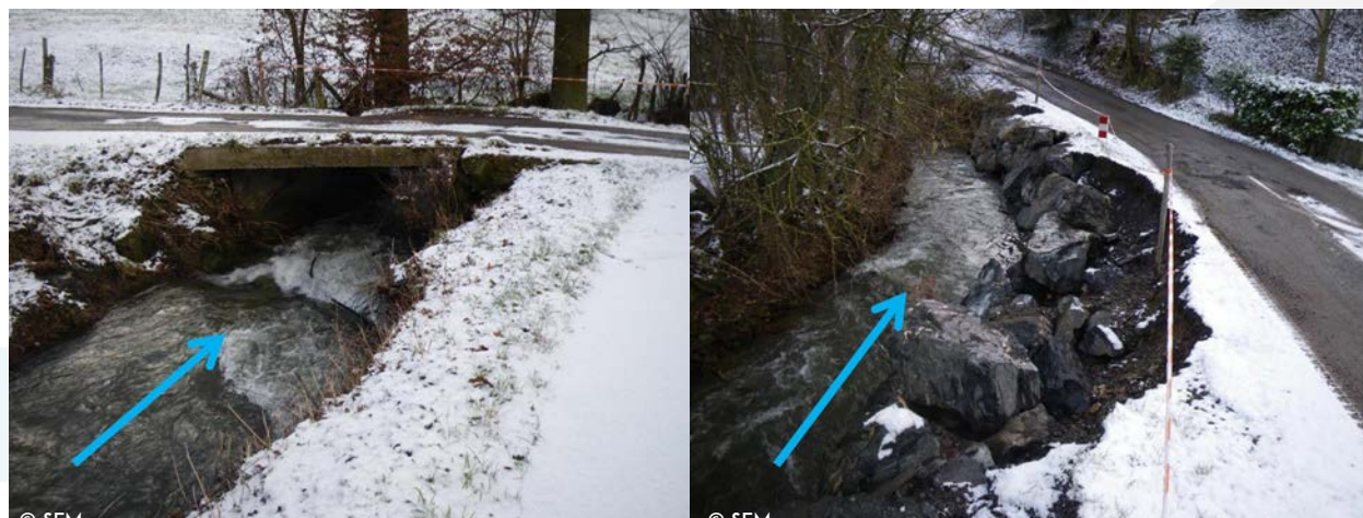
L'Onzon avant travaux
