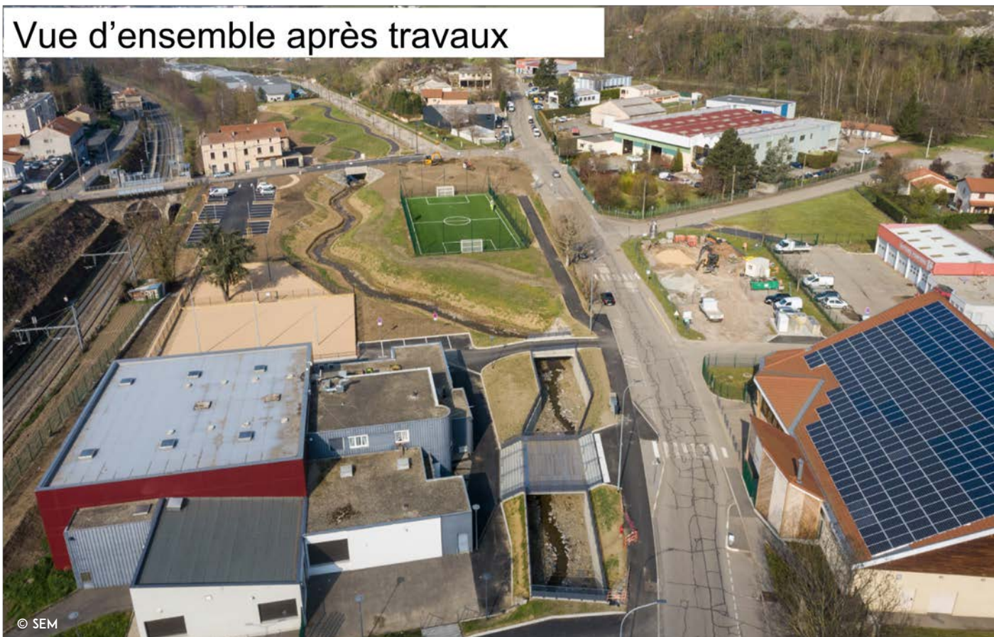
Vue aérienne post travaux du site de la Ricamarie
