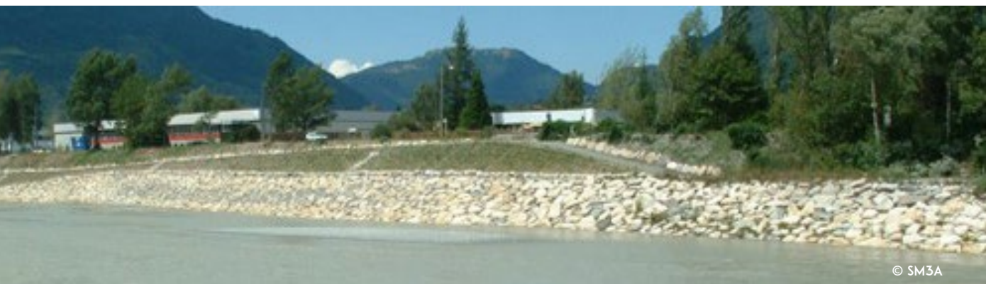
Exemple d'enrochements sur l'Arve
