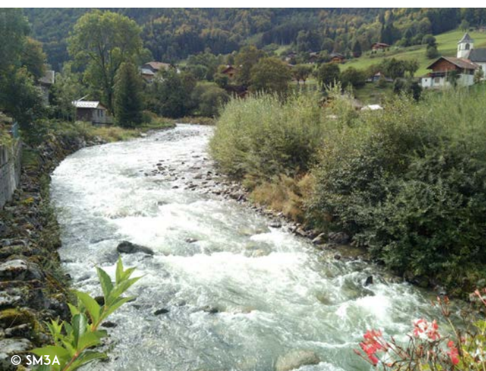
Le Borne avant travaux et post travaux
