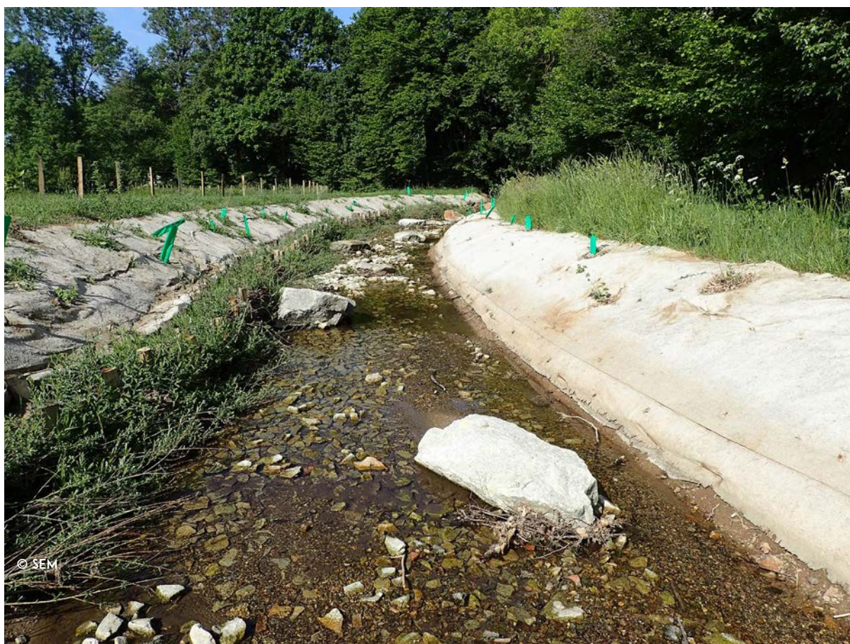
L'Onzon post travaux
