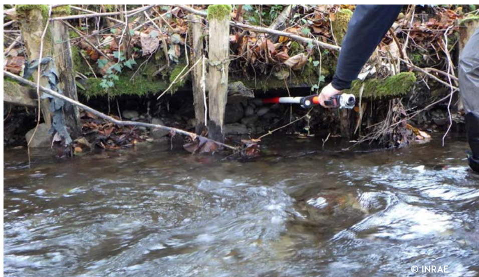
Érosion et sous cavage en pied de fascine
