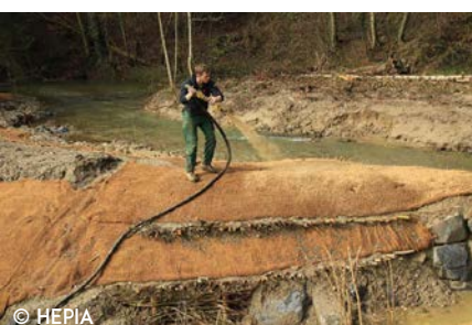
Ensemencement hydraulique
