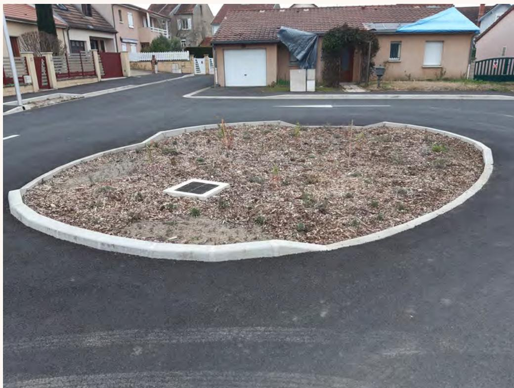
**Rond-point avec système d'infiltration
