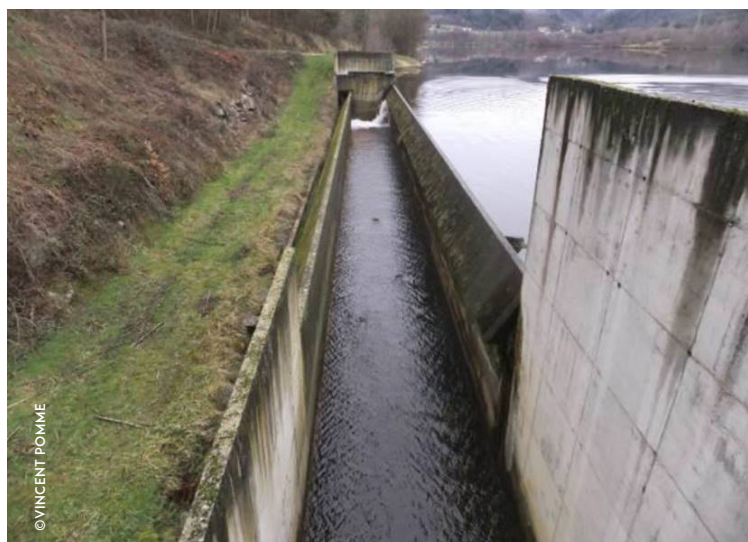
Déversoir du barrage
