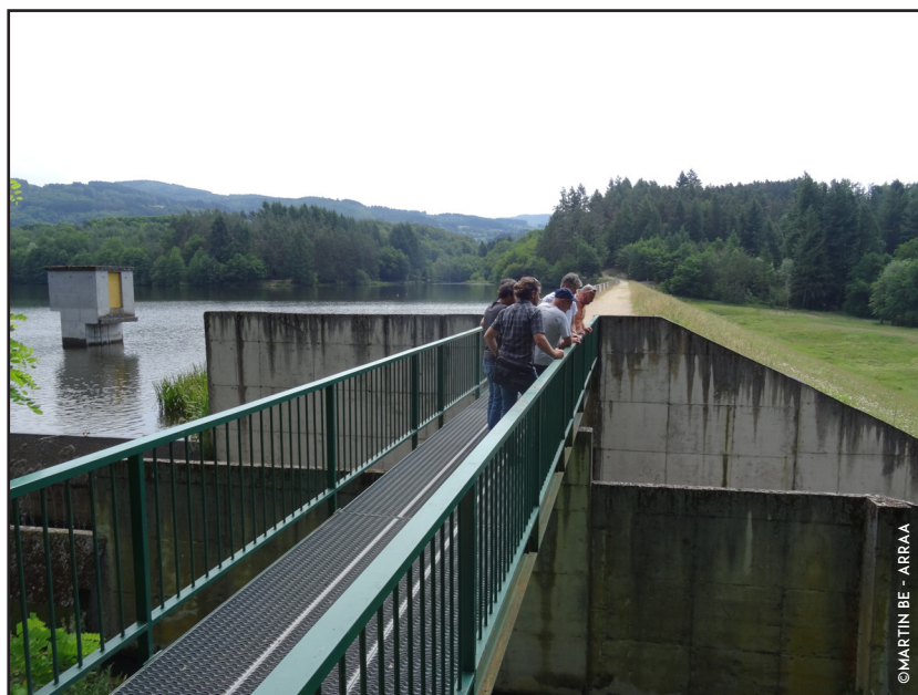
Visite du déversoir à Aubusson
