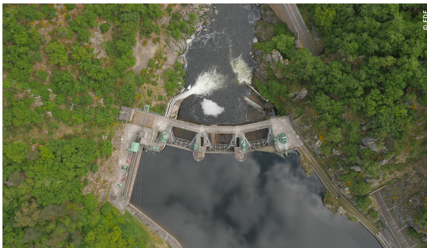
Vue aérienne du barrage de Poutès
