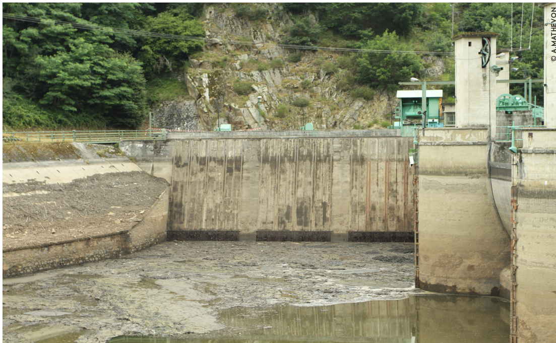
Accumulation de matériaux flottants devant la prise d'eau
