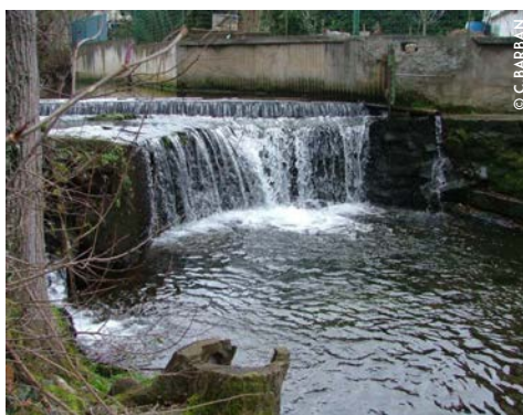
Seuil intermédiaire avant travaux
