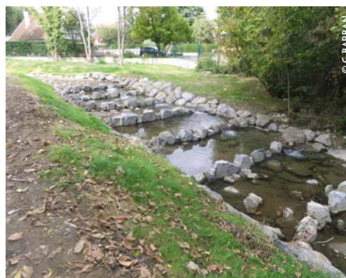
Seuil du Moulin Dermain après travaux
