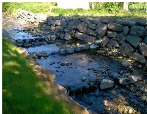
Seuil de Pourliat après travaux
