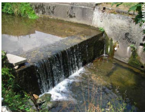
Seuil de Pourliat avant travaux
