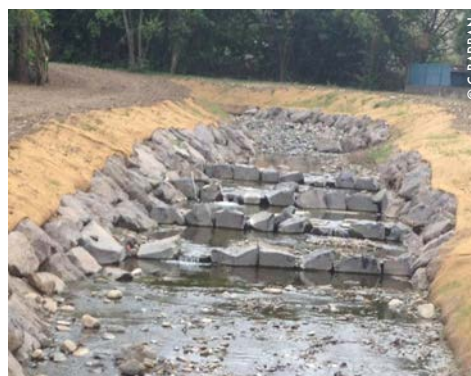
Seuil intermédiaire après travaux
