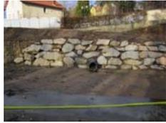
Sortie du drain de collecte des eaux derrière la digue (en attente pose clapet anti retour)
