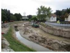
Remblaiement et compactage de la digue derrière le mur de soutènement en gabions (septembre 2012)
