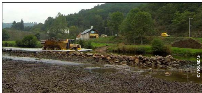
Engin de chantier traversant la Sioule
