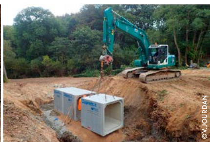
Préparation de la pose, pose des de la buse cadre et vue après travaux
