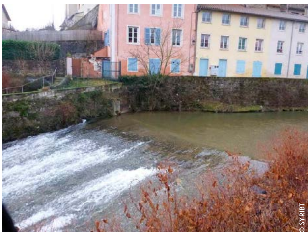
Le seuil avant travaux et les quais
