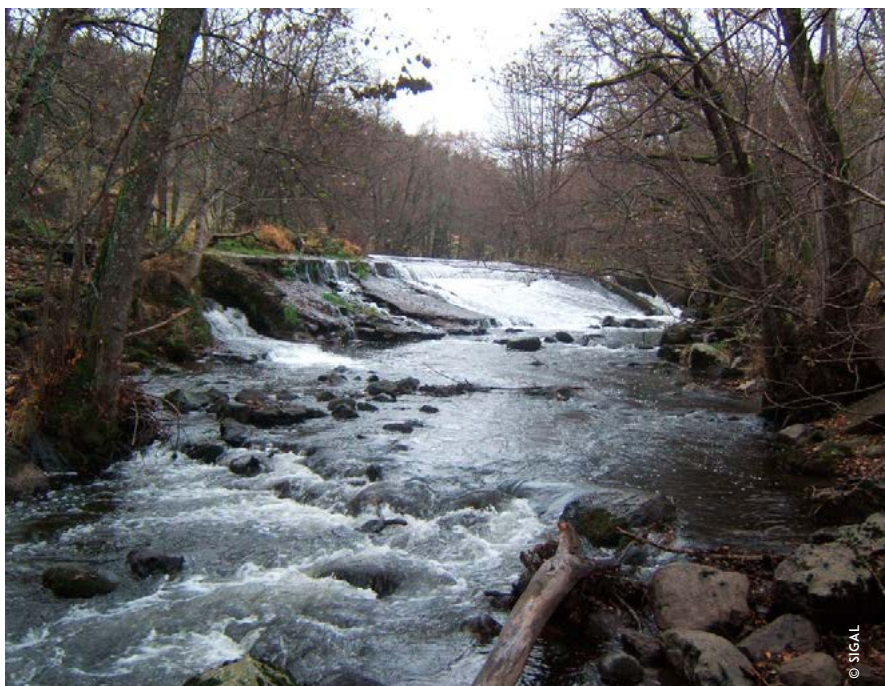
Le seuil de Stalapos avant travaux en 2004
