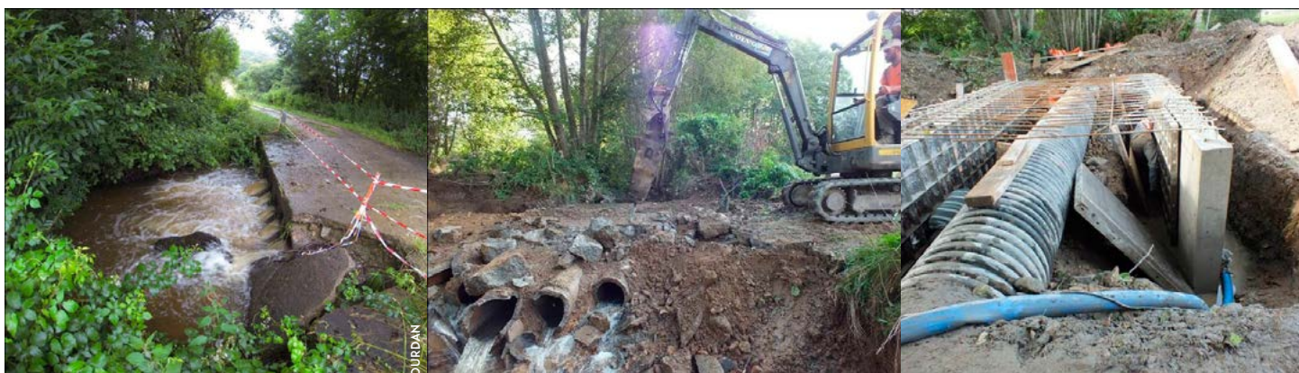
Passage à gué busé à Youx (63) : situation initiale, démolition du passage à gué et réalisation du pont autour de la dérivation
