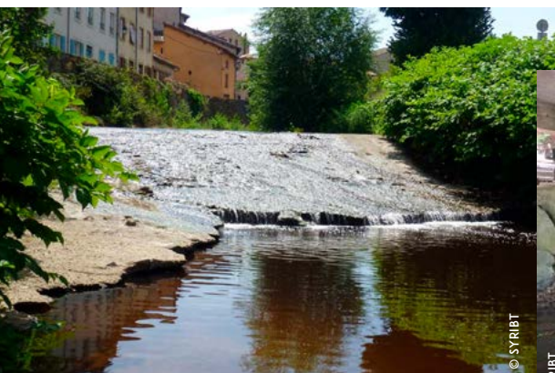
Seuil de Sapéon avant travaux
