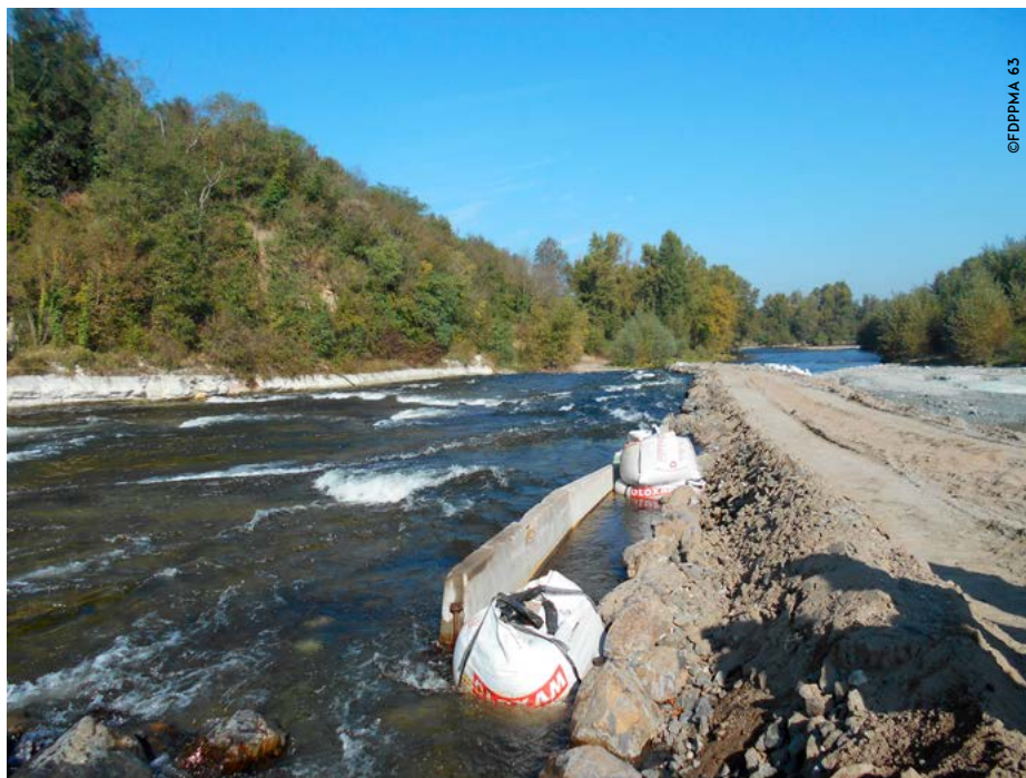
Arasement du seuil des Madeleines sur l'Allier
