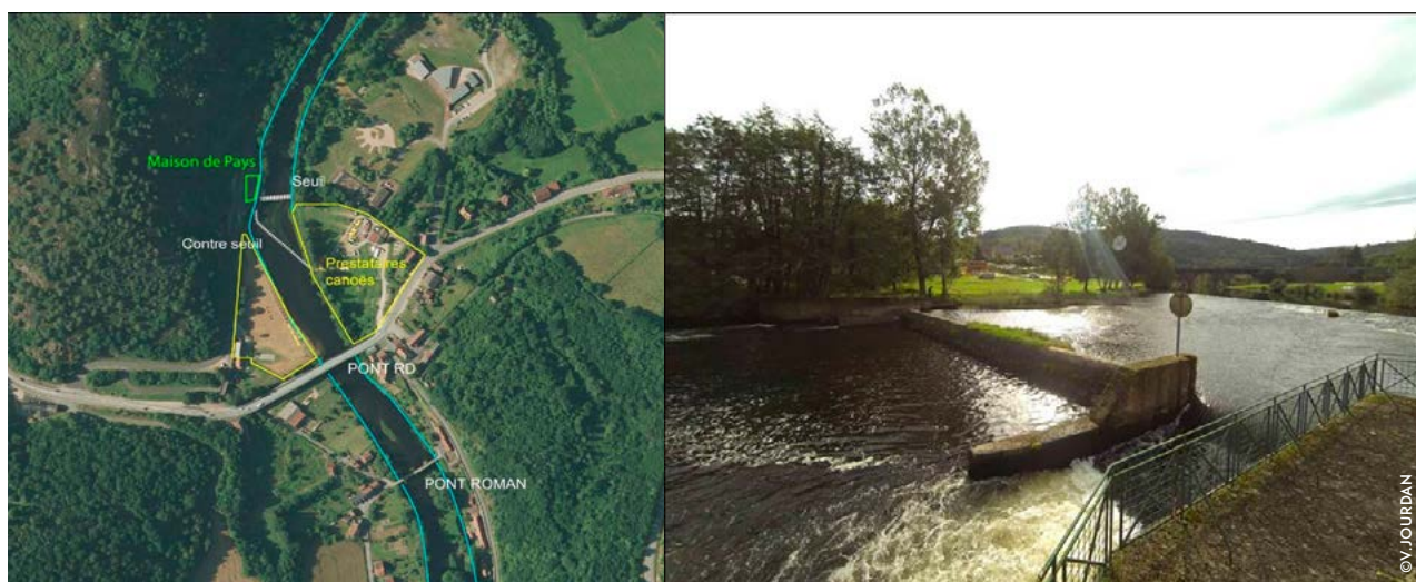
Le seuil du Pont de Menat : situation et vue avant travaux
