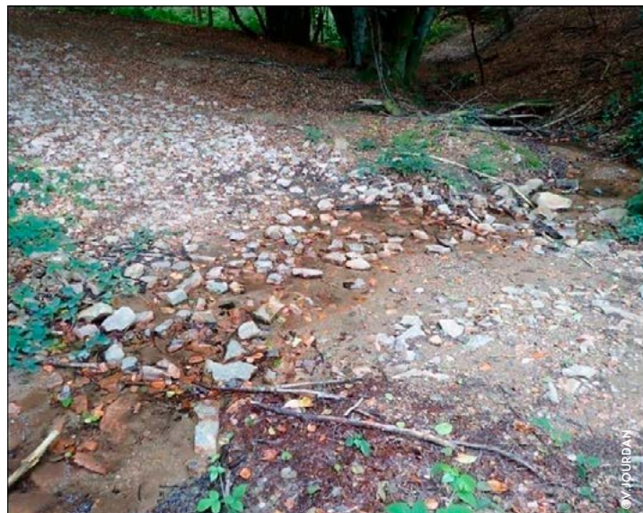
Vue du passage à gué empierré après travaux
