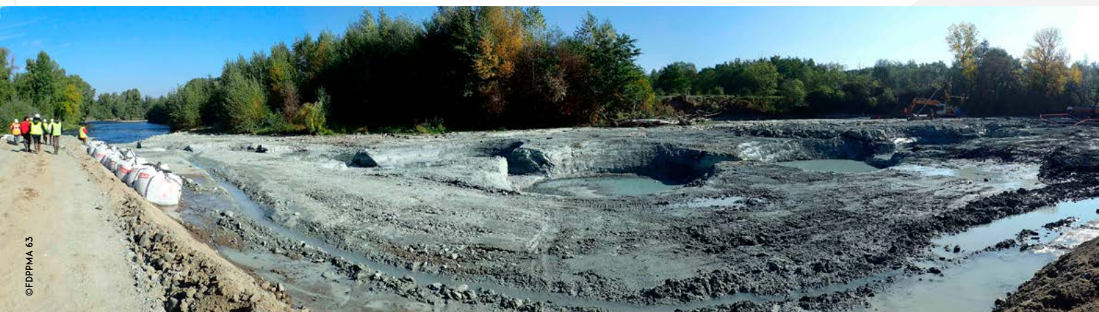
Arasement du seuil des Madeleines sur l'Allier
