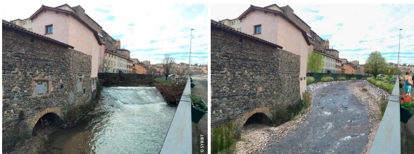
Seuil Sapéon avant et après effacement
