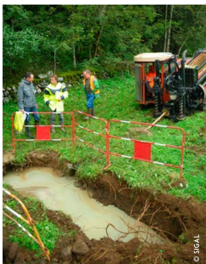
Travaux d'enfouissement de la conduite d'eau potable
