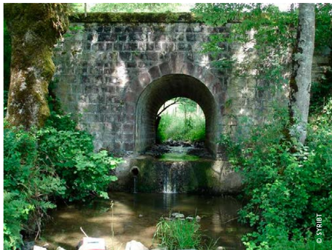
Le pont du hameau des rivières avant travaux
