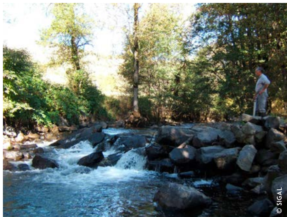
Le seuil en enrochement libre sur l'Allanche avant effacement
