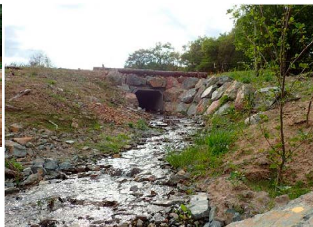
Préparation de la pose, pose des de la buse cadre et vue après travaux
