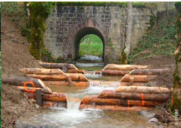
Le pont du hameau des rivières après travaux
