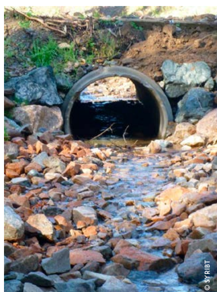
Aménagement du franchissement forestier Voisinée Marsande
