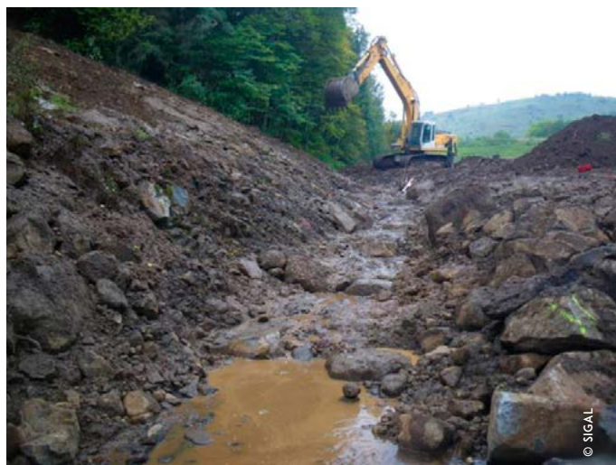
Travaux sur le ruisseau de Rechaydrat
