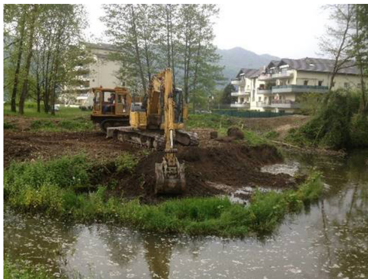
Travaux sur le Tillet
