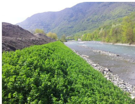
Végétalisation des parements de digues
