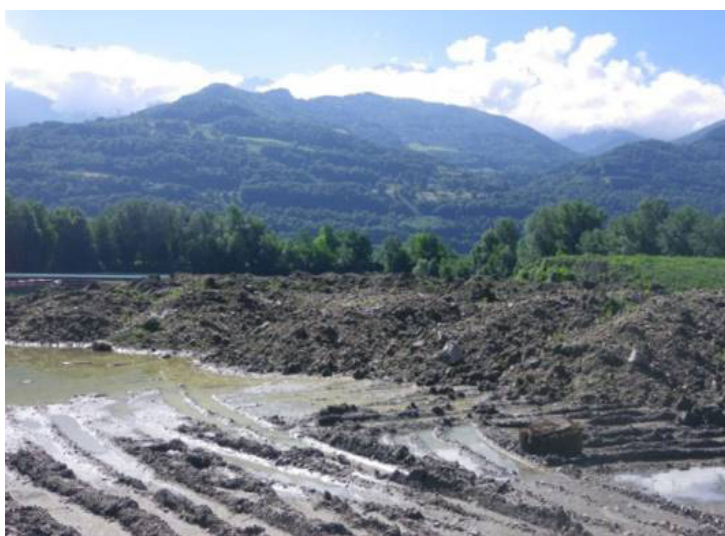
Enfouissement en gravière en eau
