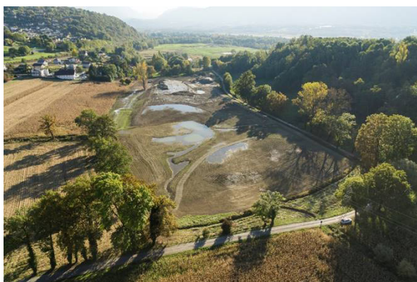
Réhabilitation en zone humide d'une décharge envahie par la renouée
