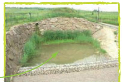
**Ouvrage de rétention et remédiation** : implanté à l'exutoire d'un fossé ou d'un émissaire de drainage, le dispositif est aménagé (filtre à gravier) de manière à stocker les faibles lames d'eau. L'accroissement du temps de séjour favorise la dégradation des contaminants. Lors d'épisodes pluvieux intenses, le bassin assure aussi une fonction de protection contre les crues.
