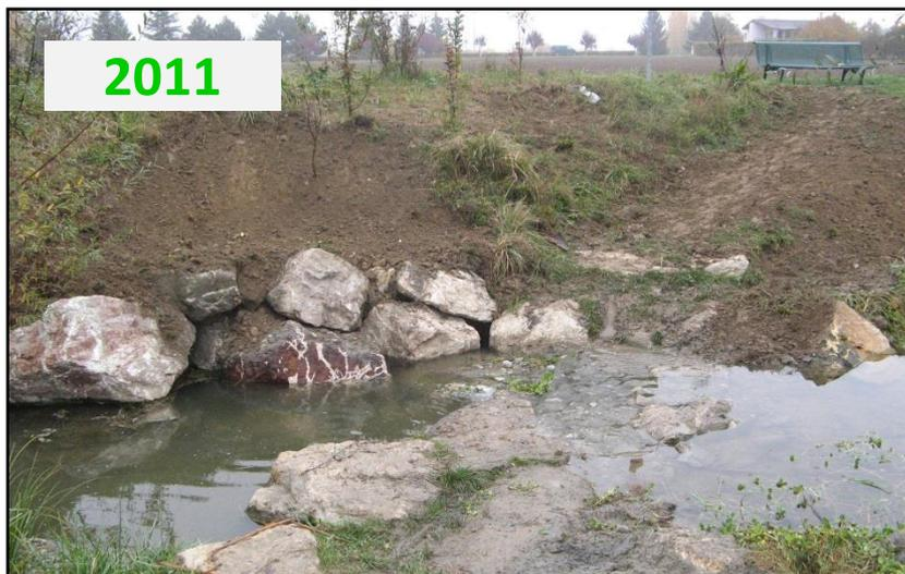
Erosion RD : 2<sup>nde</sup> reprise en enrochements
