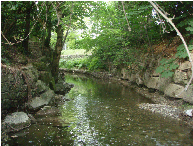
Le Foron avant les travaux (Rive gauche Ambilly - Rive droite Thônex)
