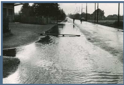
Inondation de la route de Saint-Julien en 1940.
