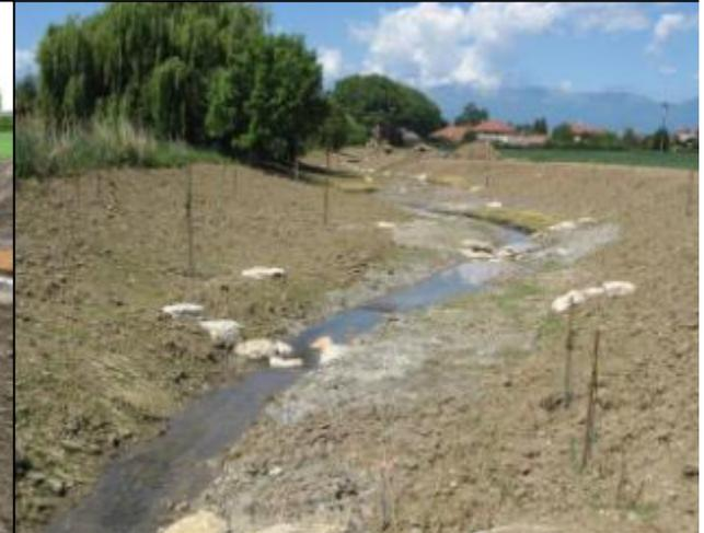
**Pendant travaux** : ouverture de la section d'écoulement, création de méandres, aménagements dans le lit mineur (caches, blocs, radiers, épis), berges en génie végétal et plantations, cheminement et passerelles
