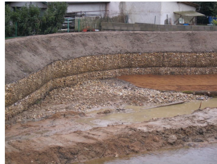
Détail de l'aménagement écologique du futur lit : épis en fascines, banquettes en graviers etc. avant implantation et reprise de la végétation au printemps (décembre 2012)
