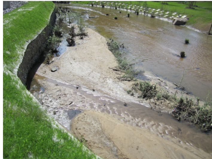
Dégâts post-crue : mesures correctives à apporter pour la gestion du transport solide mais résistance des végétaux (mai 2013)
