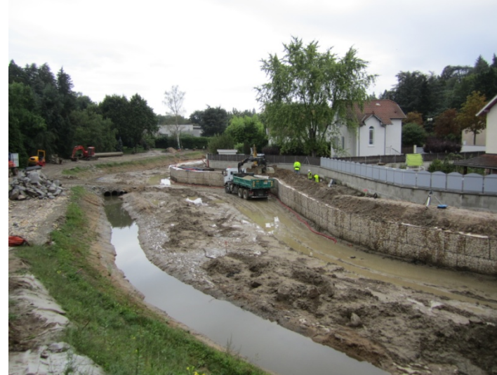
Remblaiement et compactage de la digue derrière le mur de soutènement en gabions (septembre 2012)
