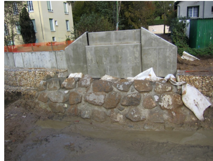
Pose des enrochements au pied des culées (novembre 2012)
