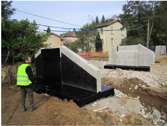
Pose des culées de la future passerelle (octobre 2012)
