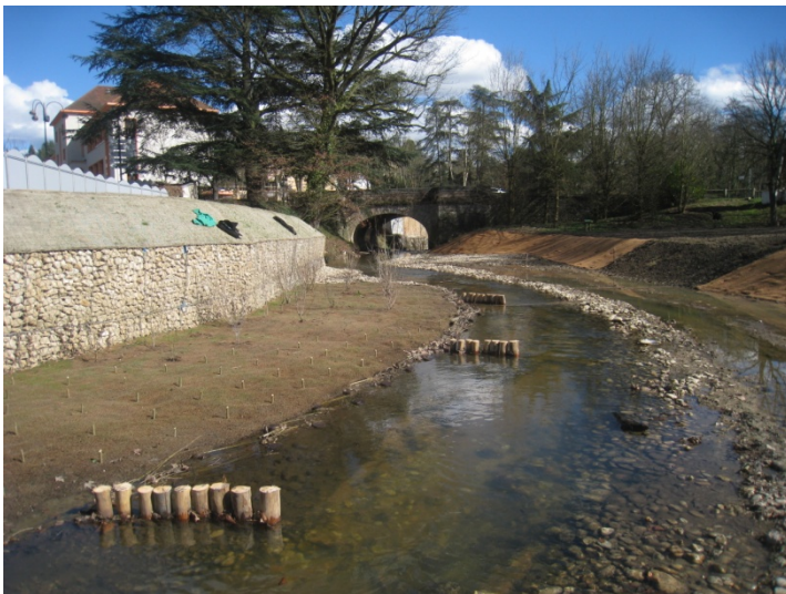
Identification des difficultés de calage des aménagements : hauteur de risberme, épis ... (mars 2013)
