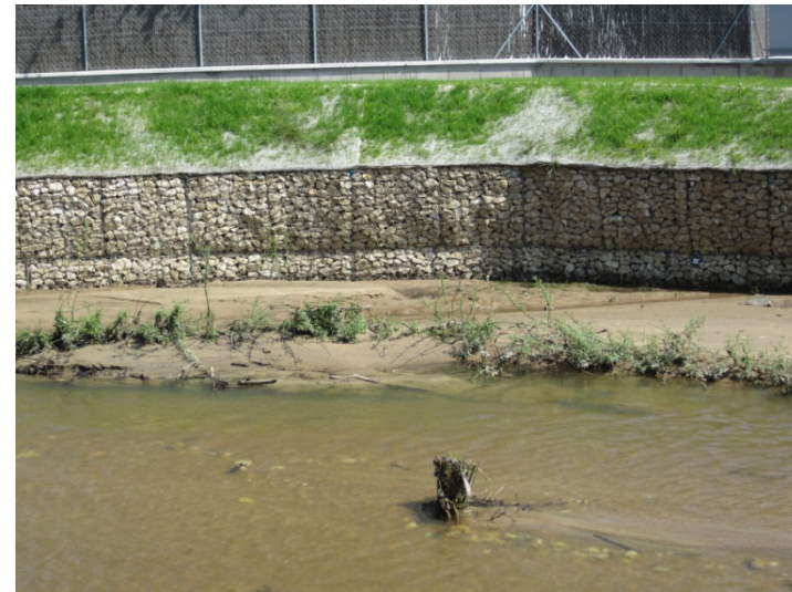
Dégâts post-crue morphogène : ensablements massifs (mai 2013)
