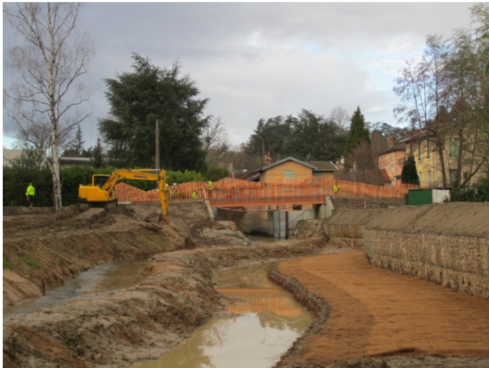
Pose du tablier de la passerelle (incluant les réseaux) et des rampes (décembre 2012)
