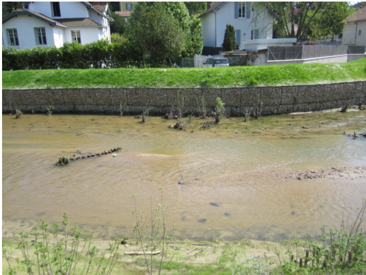
Dégâts post-crue : mesures correctives à apporter pour la gestion du transport solide mais résistance des végétaux (mai 2013)
