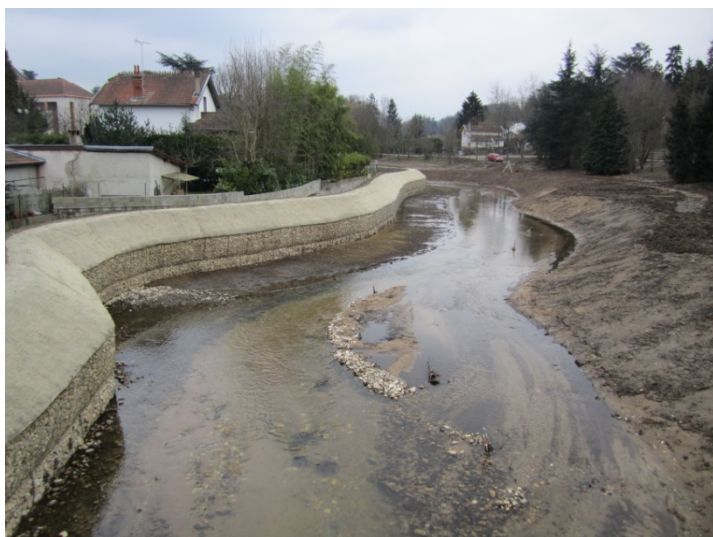
Problématique d'ensablement après les hautes eaux (mars 2013)
