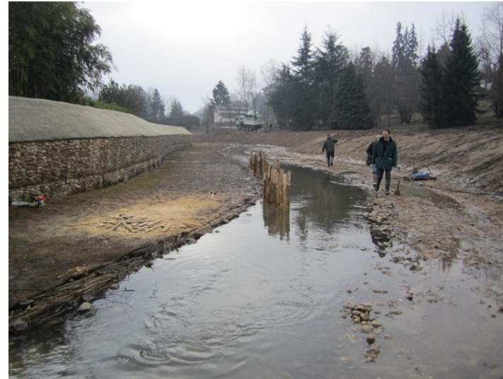
Identification des zones de tri granulométrique après les hautes eaux et reprise du chantier (mars 2013)
