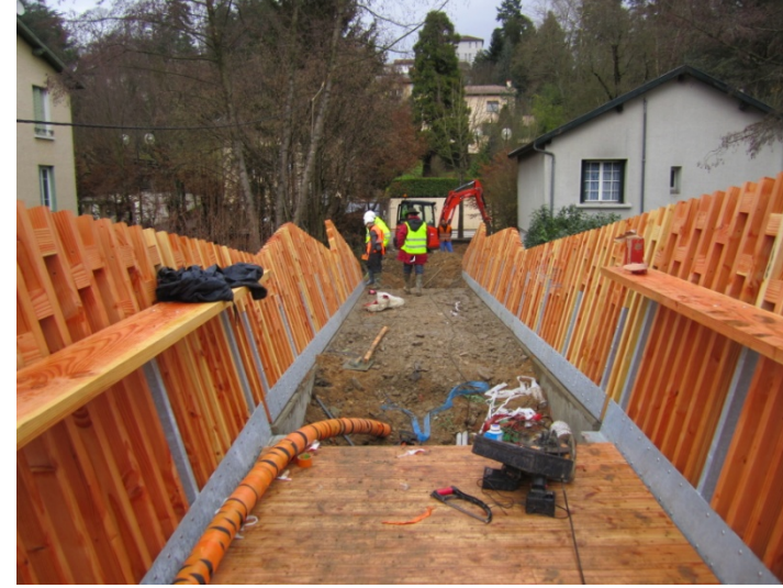
Pose du tablier de la passerelle (incluant les réseaux) et des rampes (décembre 2012)
