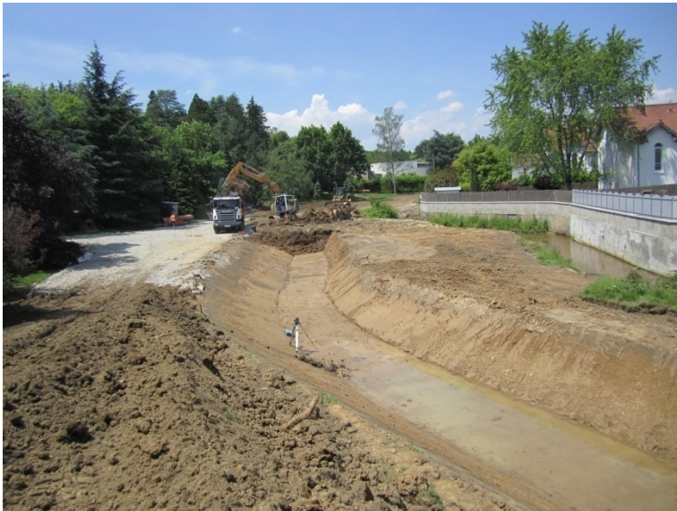
Creusement du canal de dérivation provisoire (juin 2012)
