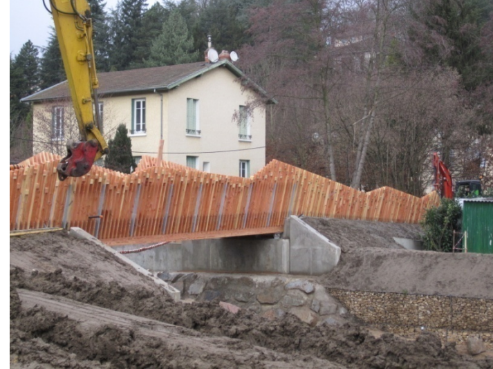
Pose du tablier de la passerelle (incluant les réseaux) et des rampes (décembre 2012)
