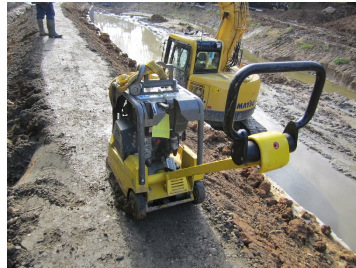
Protection par géogrille et compactage de la digue derrière le mur en gabions (novembre 2012)
