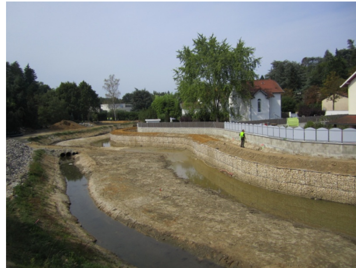
Vue d'ensemble de la digue (octobre 2012)
