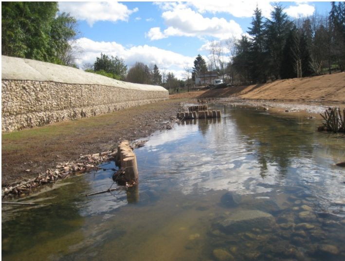
Identification des difficultés de calage des aménagements : hauteur de risberme, épis ... (mars 2013)
