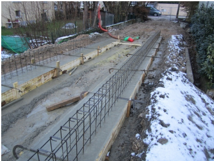
Fondation des futures rampes de la passerelle
