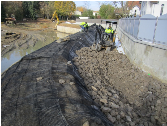
Protection par géogrille et compactage de la digue derrière le mur en gabions (novembre 2012)
