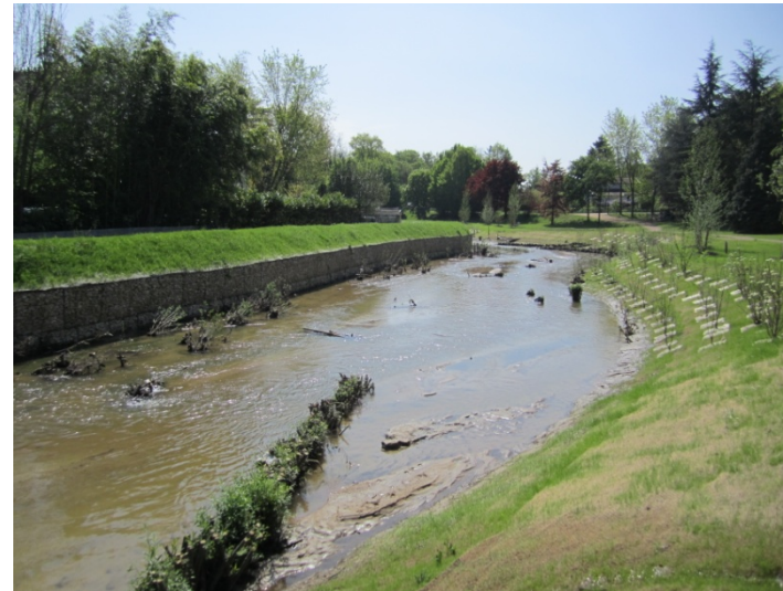
Dégâts post-crue : mesures correctives à apporter pour la gestion du transport solide mais résistance des végétaux (mai 2013)
