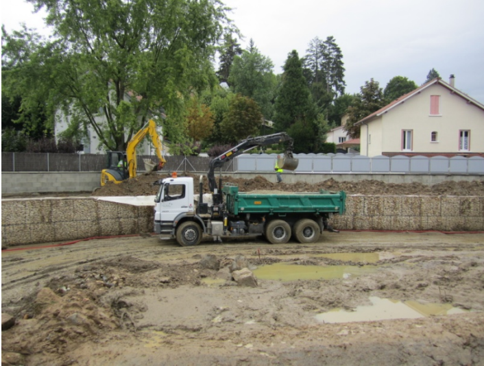
Remblaiement et compactage de la digue derrière le mur de soutènement en gabions (septembre 2012)
