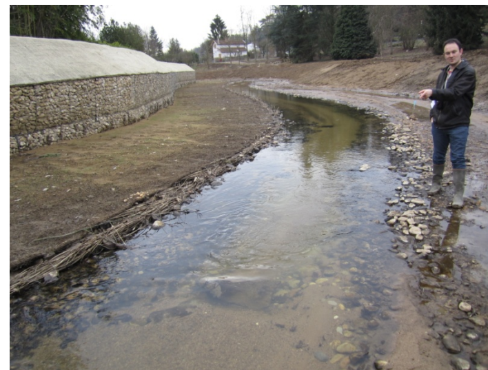
Problématique d'ensablement après les hautes eaux (mars 2013)
