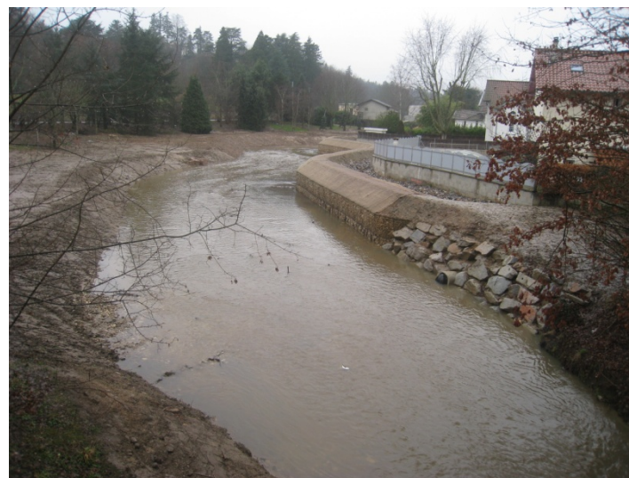
Reconstitution d'un substrat graveleux (janvier 2013) et interruption du chantier en hautes eaux (février 2013)
