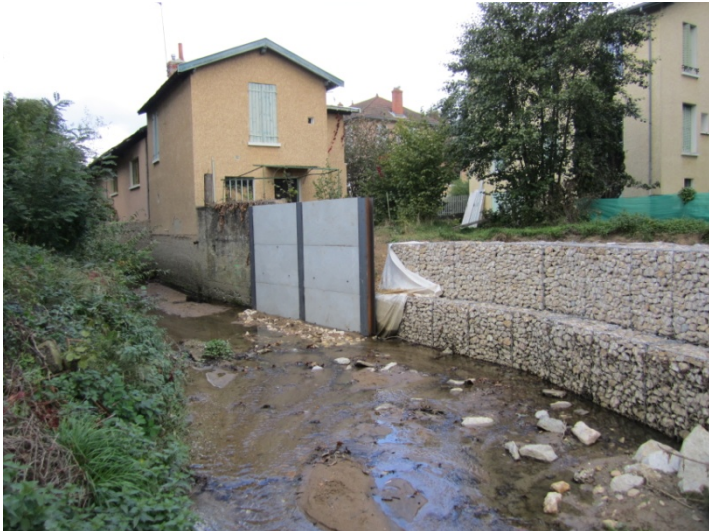
Mise en place d'un mur de soutènement en paroi berlinoise (octobre 2012)
