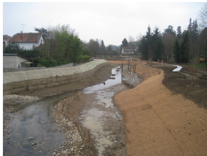
Identification des difficultés de calage des aménagements : hauteur de risberme, épis ... (mars 2013)
