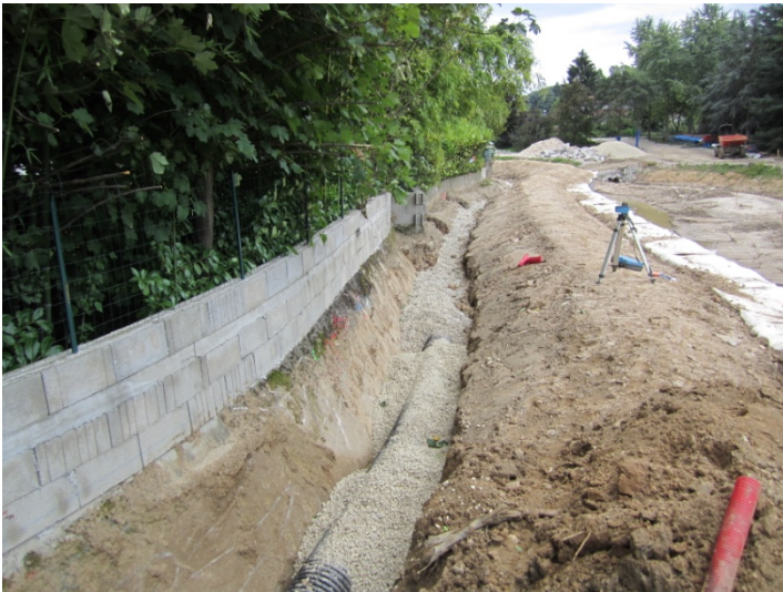
Pose d'un drain de collecte des eaux pluviales et des eaux de surverse derrière la digue
