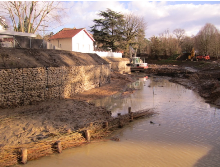
Détail de l'aménagement écologique du futur lit : épis en fascines, banquettes en graviers etc. avant implantation et reprise de la végétation au printemps (décembre 2012)
