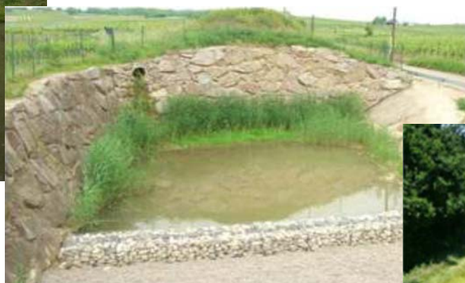
Ouvrage de rétention et remédiation
