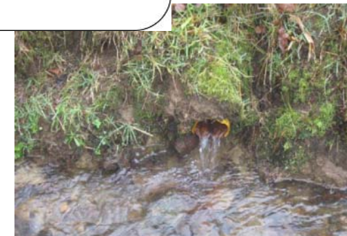
Drain primaire amenant directement l'eau au réseau hydrographique
