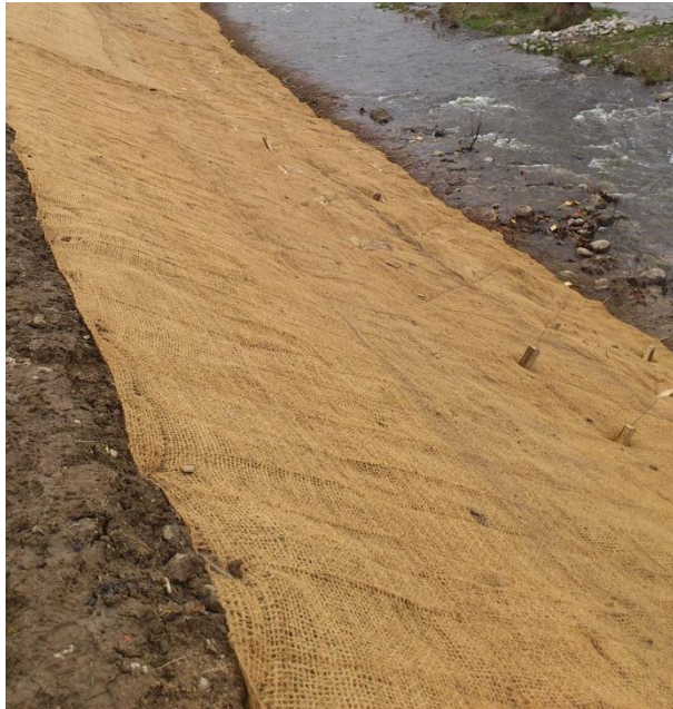
Semis herbacé et géotextile
