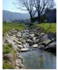
Il convient de réserver les blocs les plus gros pour le pied d'ouvrage et la semelle, et d'utiliser les plus petits sur le haut de l'ouvrage et les derniers rangs du montage. A ces fins, on conseille vivement d'opter pour une organisation de chantier permettant aux opérateurs réalisant le montage de toujours disposer de matériaux d'avance, au cours de l'opération, afin de permettre un choix large et judicieux.
