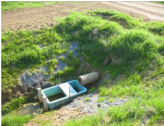
Vue sur la sortie de drain
