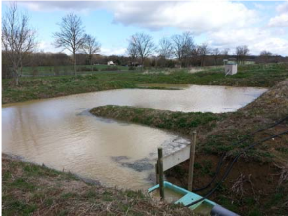
Vue générale du dispositif
