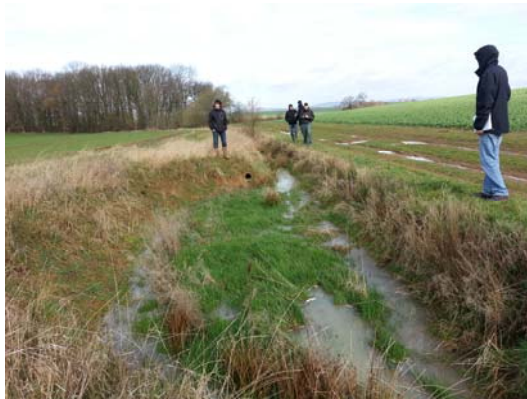
Vue vers l'aval sur la zone élargie pour la décantation
